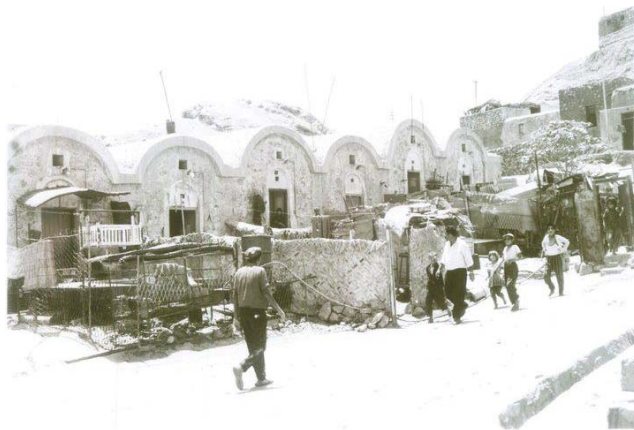
شکل ۳. خانه‌های کارگری در مسجدسلیمان
